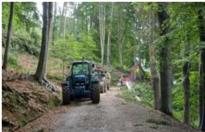
I LAVORI DI MESSA IN SICUREZZA DEL PARCO DELLA BURCINA
