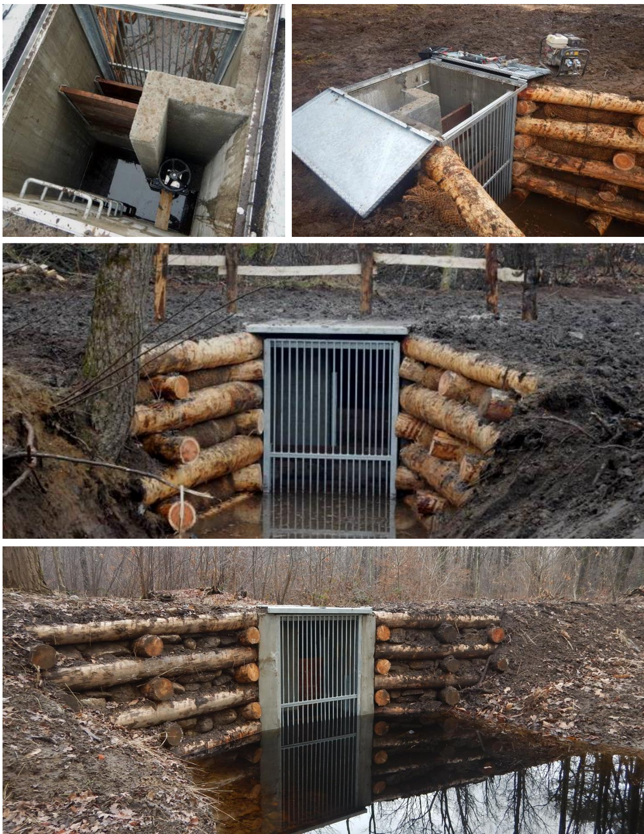
Figura 16: Fasi di costruzione di una chiusa Idobat, tipo Peverascia, e risultato finale. Negli esempi la sua prima applicazione presso l'acquitrino della Peverascia (Arsago Seprio) ed in seguito alla palude della Moriggia (Gallarate)
