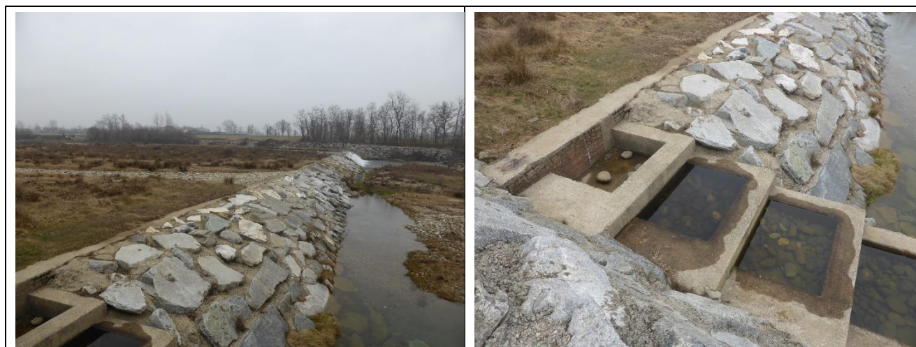
1° dislivello impercorribile e dettaglio del "passaggio per pesci"
