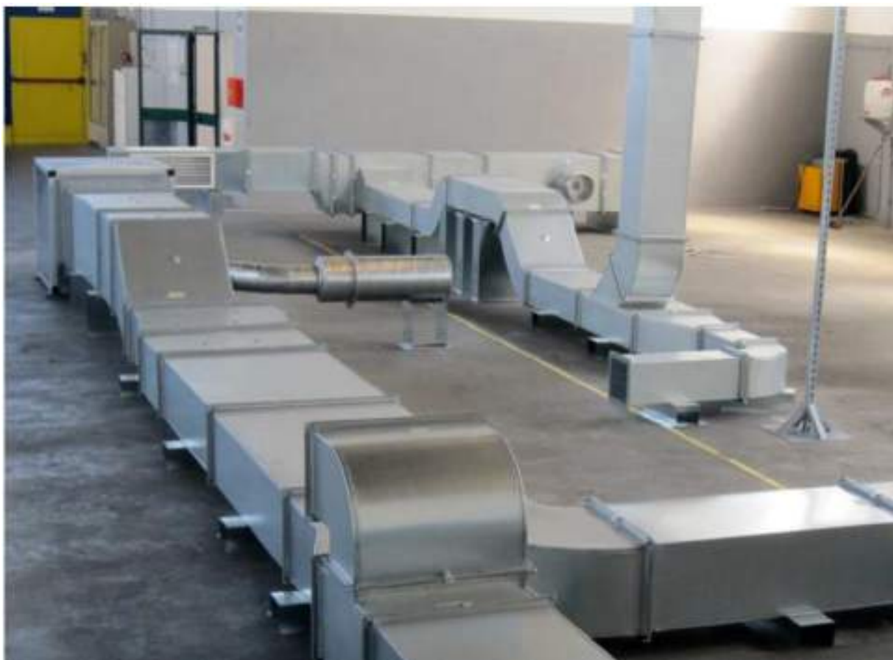
Figura 12 – Condotte in rettangolare zincate e pezzi speciali
