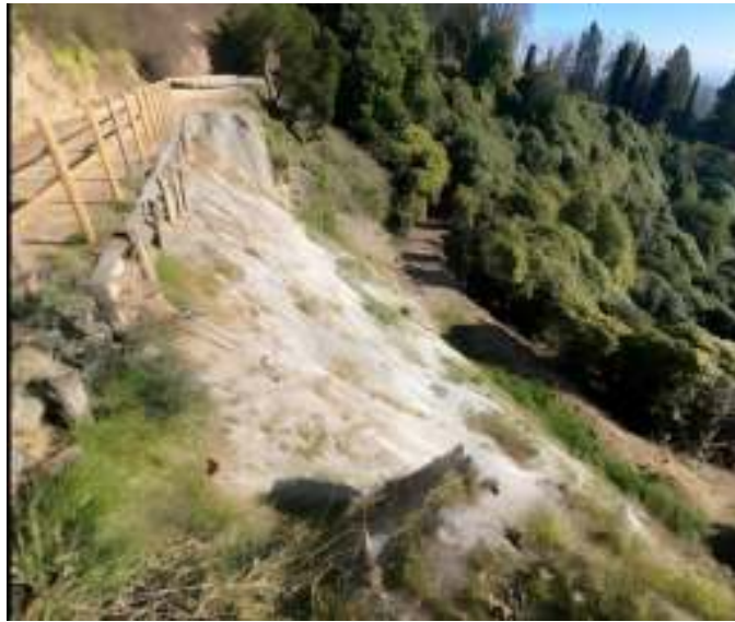
IL VERSANTE da sistemare. I lavori previsti nel corso del 2024
